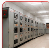
MV SWITCHGEAR
